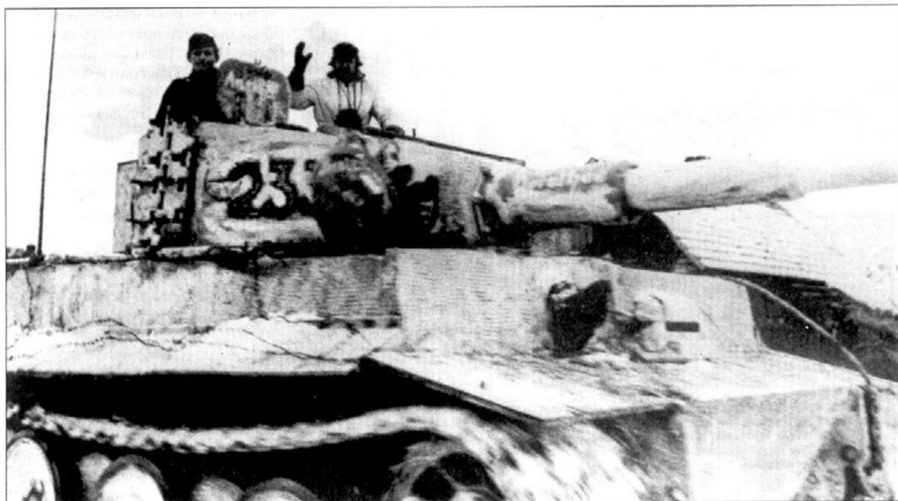
Крупный план Тигра I из 502-го тяжелого танкового батальона, хорошо видна поверхность циммеритового покрытия и личное имя машины - «Дороти» (Dorothee), написанное белым поверх темно-желтой базовой окраски (на стволе). Белое камуфляжное покрытие грубое, нанесенное кистями или губками, что было обычной практикой. Tактический номер на башне - желтый с черной обводкой.
