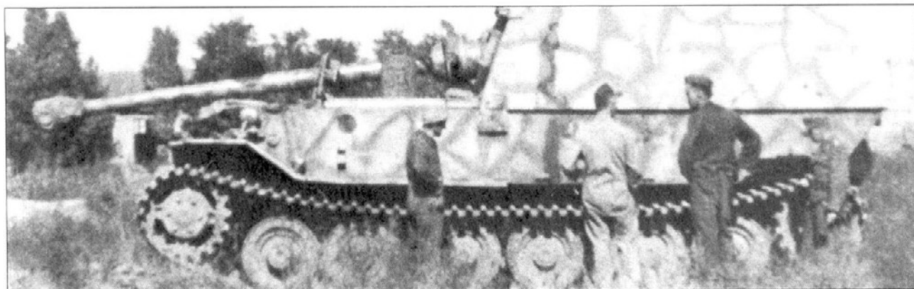
Эта фотография «Фердинанда» номер «612» дает представление о типичном внешнем виде этих машин в период Курляндской битвы. Узор из оливково-зеленых полос на темно-желтом фоне использовался чтобы «расчленил» силуэт этой довольно крупной машины. Тактический номер нарисован белой краской. На корпусе и рубке уже видны потеки масла и пятна другого происхождения.
