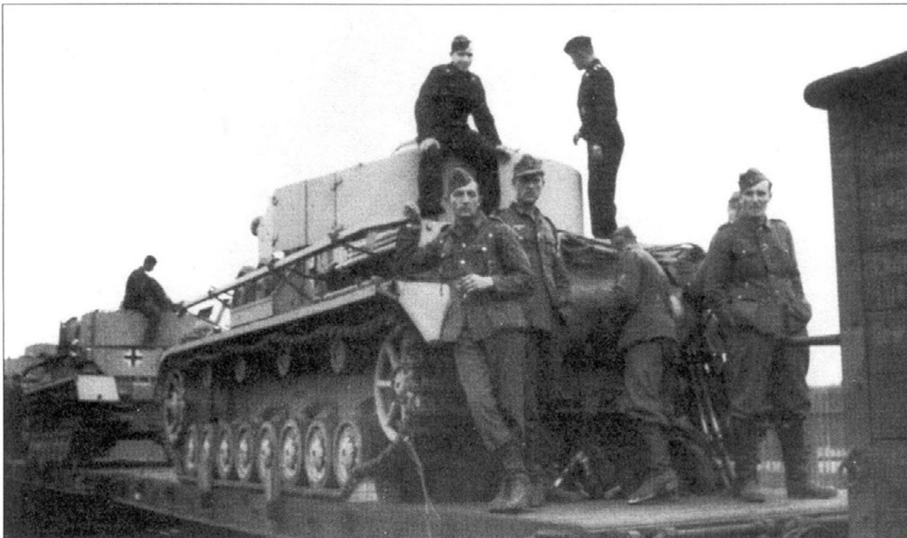
Новенькие PzKpfw IV Ausf. G прибыли в Брянск, 1943 г. На лицах солдат можно прочесть тревожную озабоченность. Танки надежно закреплены на платформах: притянуты толстой проволокой, под гусеницы подложены «башмаки», вертикальные бруски вставлены в специальные пазы по бортам платформы. Бортовые экраны сняты и, по-видимому, перевозятся в другом вагоне.
