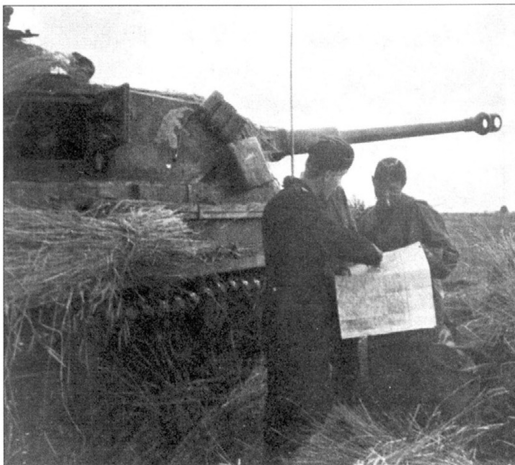
Замаскированный PzKpfw IV Ausf. G из 16-й танковой дивизии, Юг Италии, 1943 г. Танк поздней модификации, о чем говорит одностворчатый люк командира и удлиненная до 48-ми калибров пушка. Из-за полного господства союзников в воздухе немцам приходилось тщательно маскировать свою бронетехнику.
