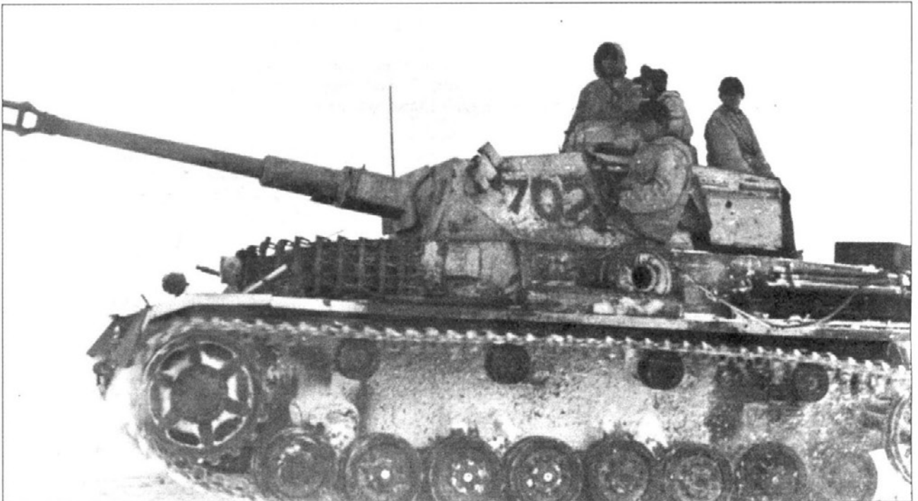
PzKpfw IV Ausf. G на заснеженных просторах России, зима 1943/44 г. Легкосмываемая белая краска сильно поистерлась, катки, по-видимому, вообще не окрашивались и остались желтого цвета. Несмотря на наличие смотрового прибора в борту корпуса, гусеничная цепь на лобовой бронеплите охватывает еще и борт танка. Танкисты одеты в стеганые зимние куртки, которые были гораздо удобнее шинелей, стандартных для зимы 1941/42 г.
