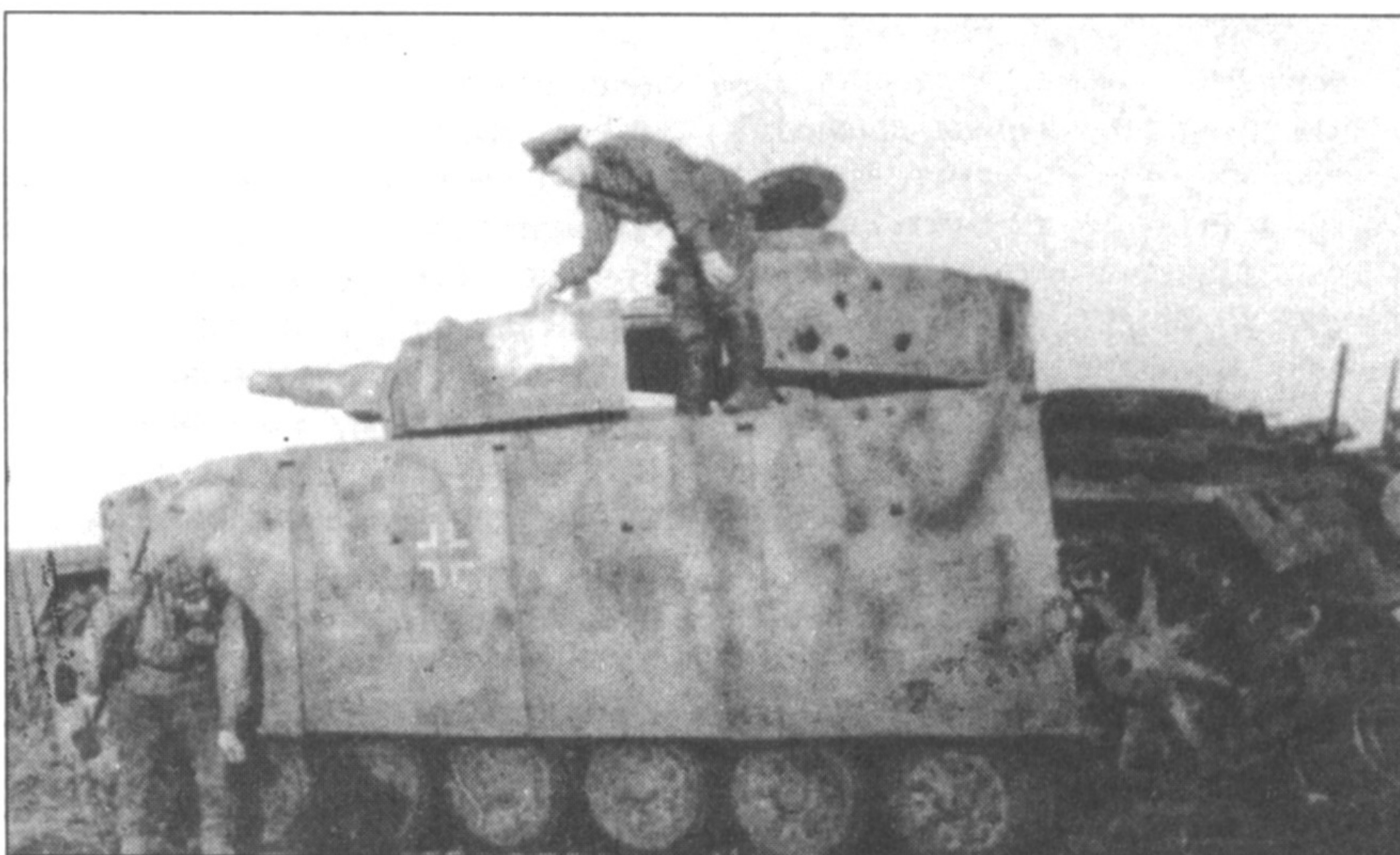
Советский офицер изучает подбитый Ausf.N. Обратите внимание на сквозные пробоины в кормовом башенном экране. Танки последних выпусков имели камуфляжную окраску - полосы темно-зеленого и красно-коричневого цвета поверх песочно-желтой основной окраски.
