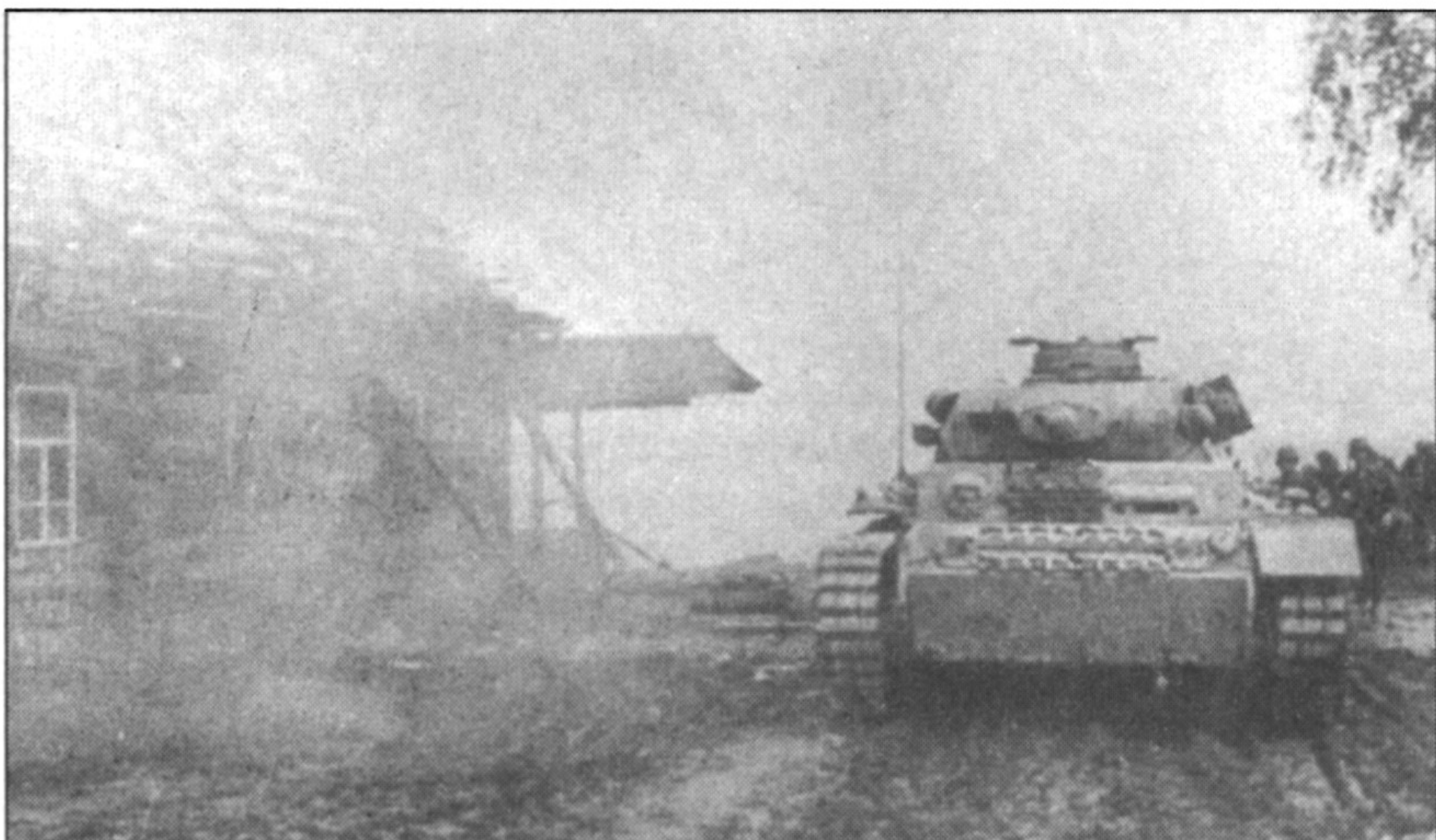
PzKpfw III Ausf. J в горящей русской деревне. Танк окрашен зимней белой краской. Обратите внимание - отсутствует передняя часть правого надгусеничного крыла. Узлы крепления крыльев к корпусу были довольно слабыми, поэтому нередко крылья или секции крыльев терялись при передвижении по пересеченной местности или в результате боевых повреждений.
