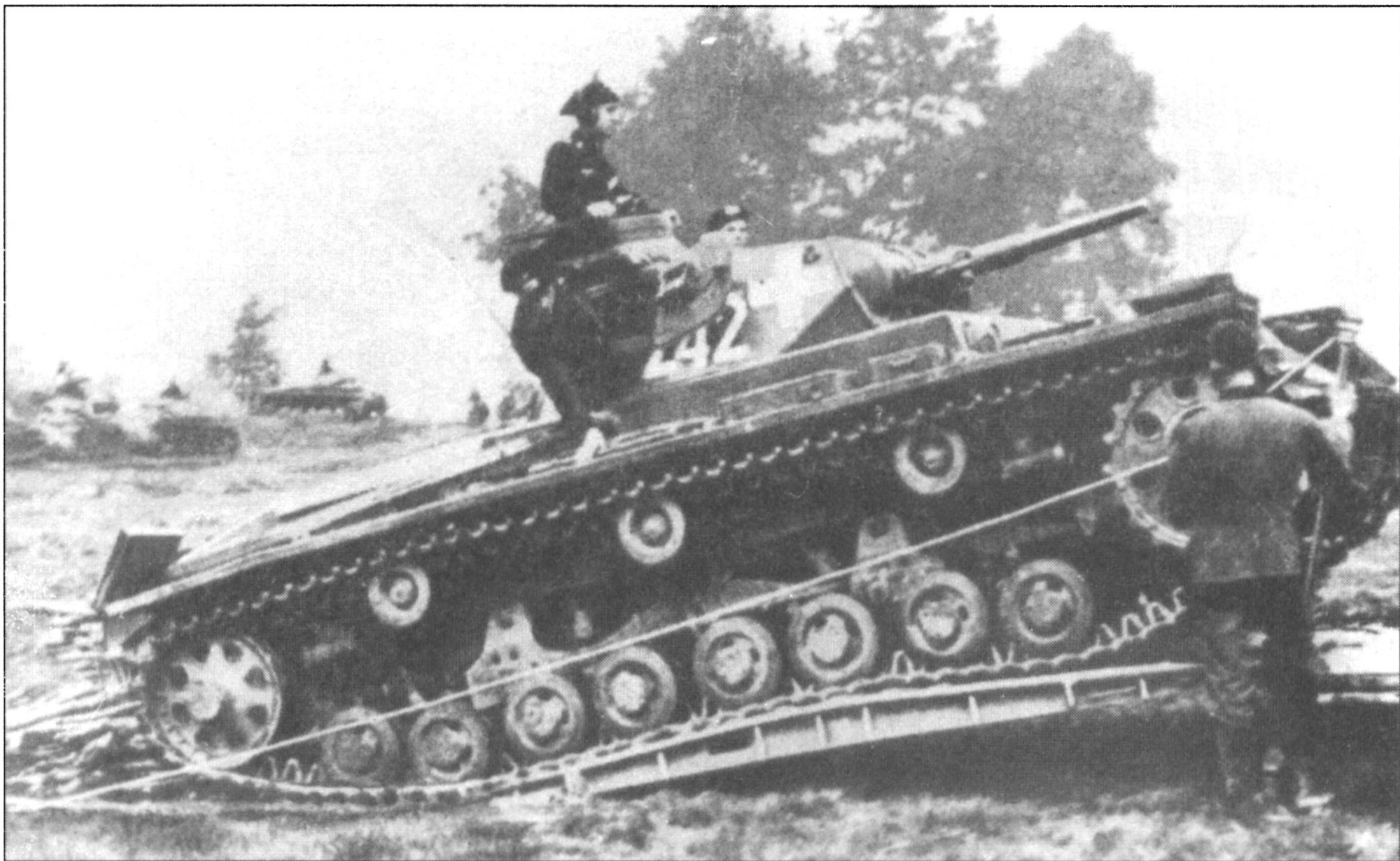
PzKpfw III Ausf.D въезжает на саперный мостик. Хорошо видно особенности варианта «D»: восьмиколесную ходовую часть, рессоры подвески, литую командирскую башенку и расширенный кормовой бронелист.
