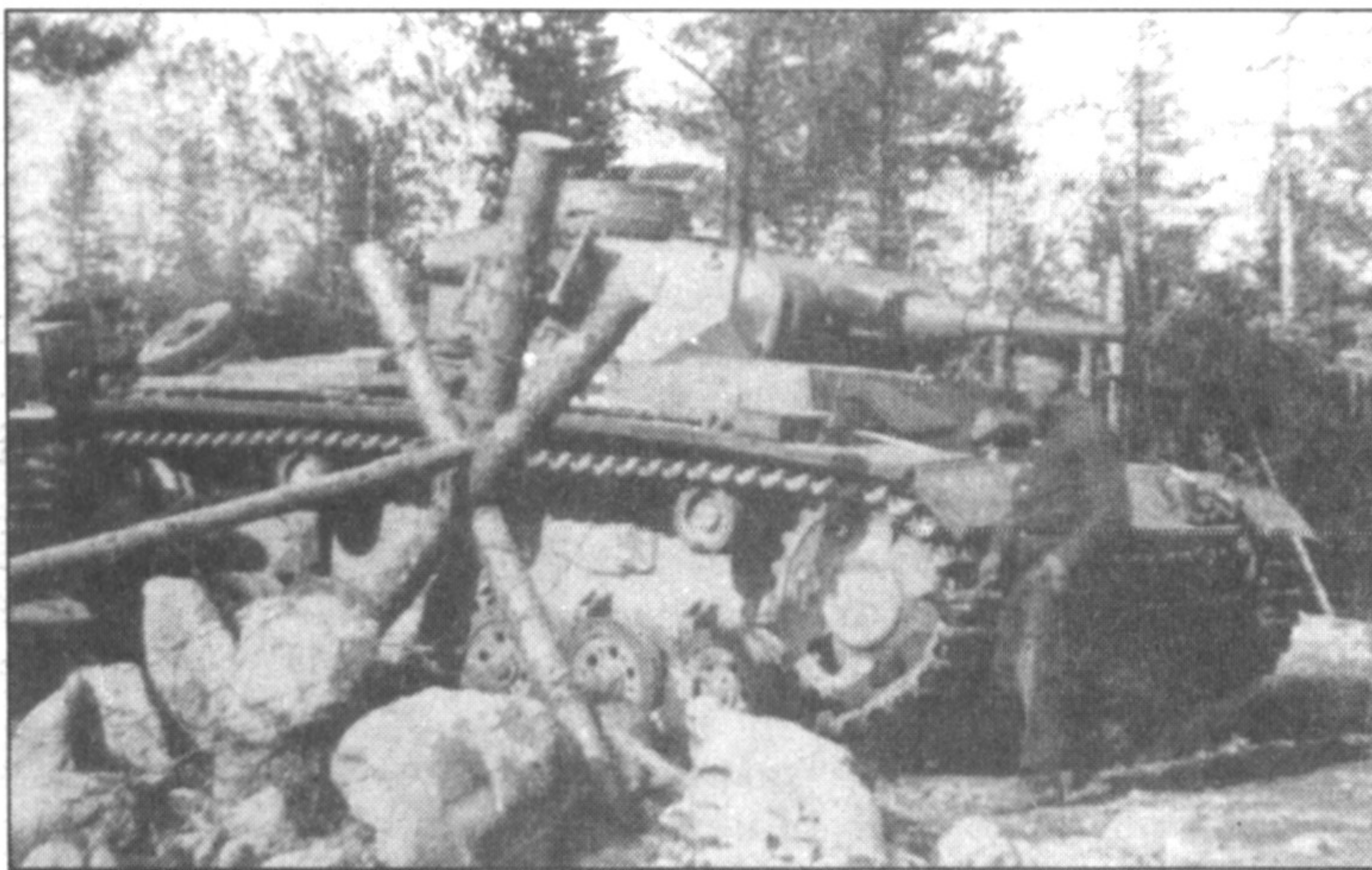
Ausf. J с открытым правым башенным аварийным люком; фактически каждый член экипажа танка мог в случае опасности покинуть танк через индивидуальный аварийный люк.
