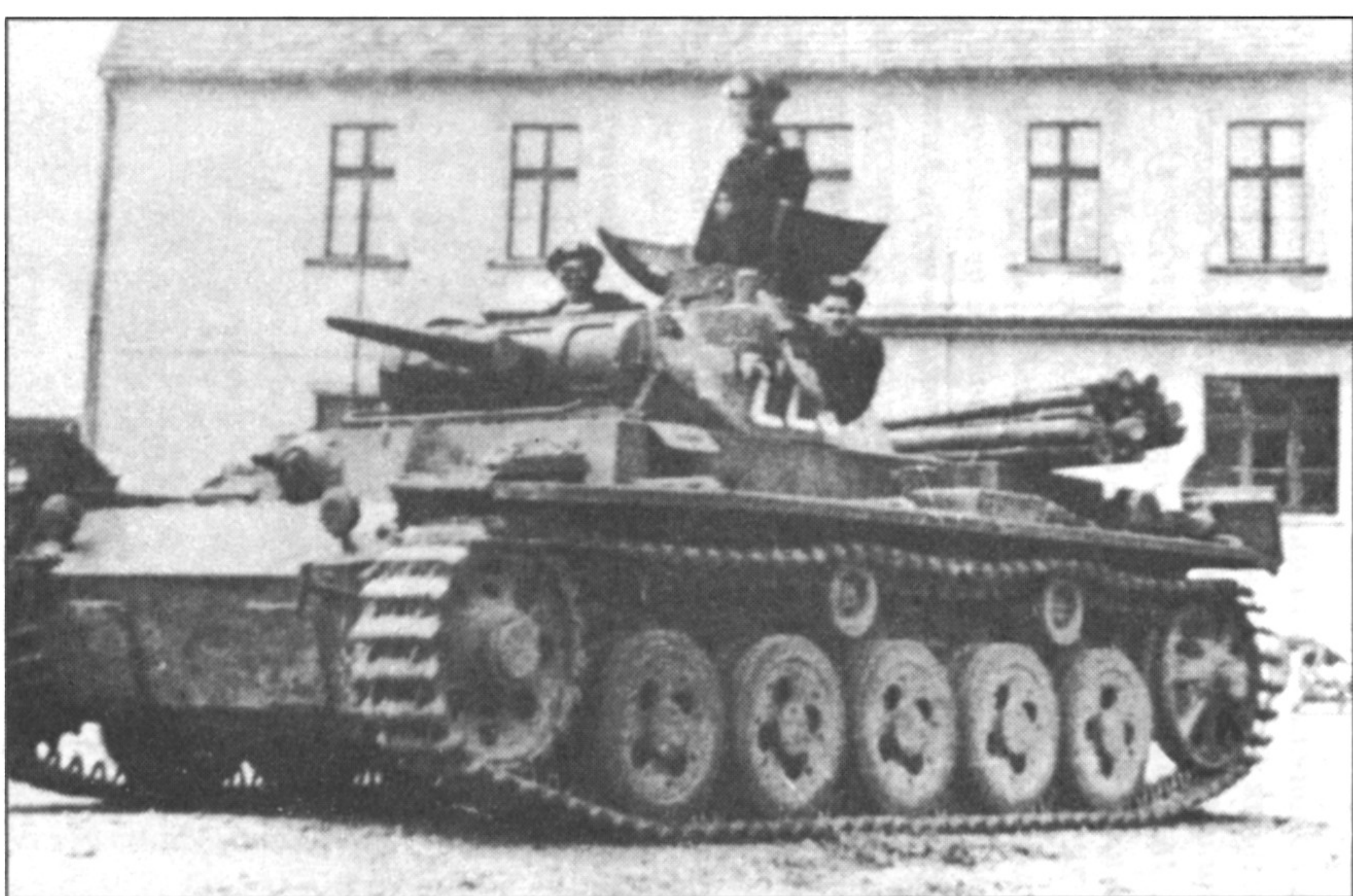
Этот PzKpfw III Ausf.A сфотографирован в 1939 г. в Польше. Курсовой пулемет на танках вариантов Ausf.A-D монтировался в шаровой установке. Обратите внимание на крест желтого цвета на борту башни.
