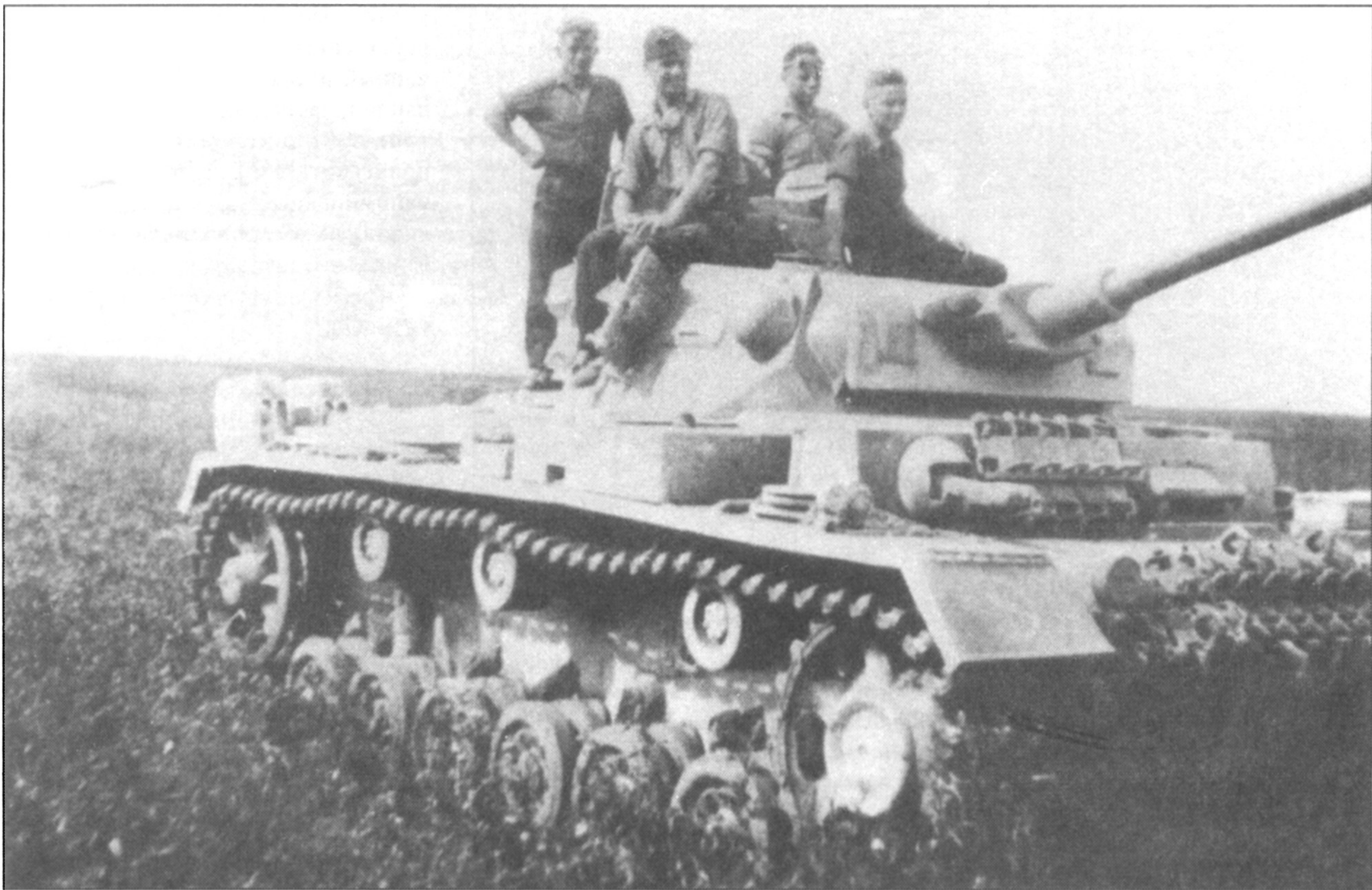
PzKpfw III Ausf.J, вооруженный длинноствольной 50-мм пушкой. Несмотря на то, что орудие с длиной ствола 60 калибра значительно превосходило короткоствольную пушку такого же калибра, оно все равно оказалось неспособно эффективно бороться с советскими танками. В Северной Африке танки Ausf.J с длинноствольными пушками получили у англичан обозначение «Mk.III special».
