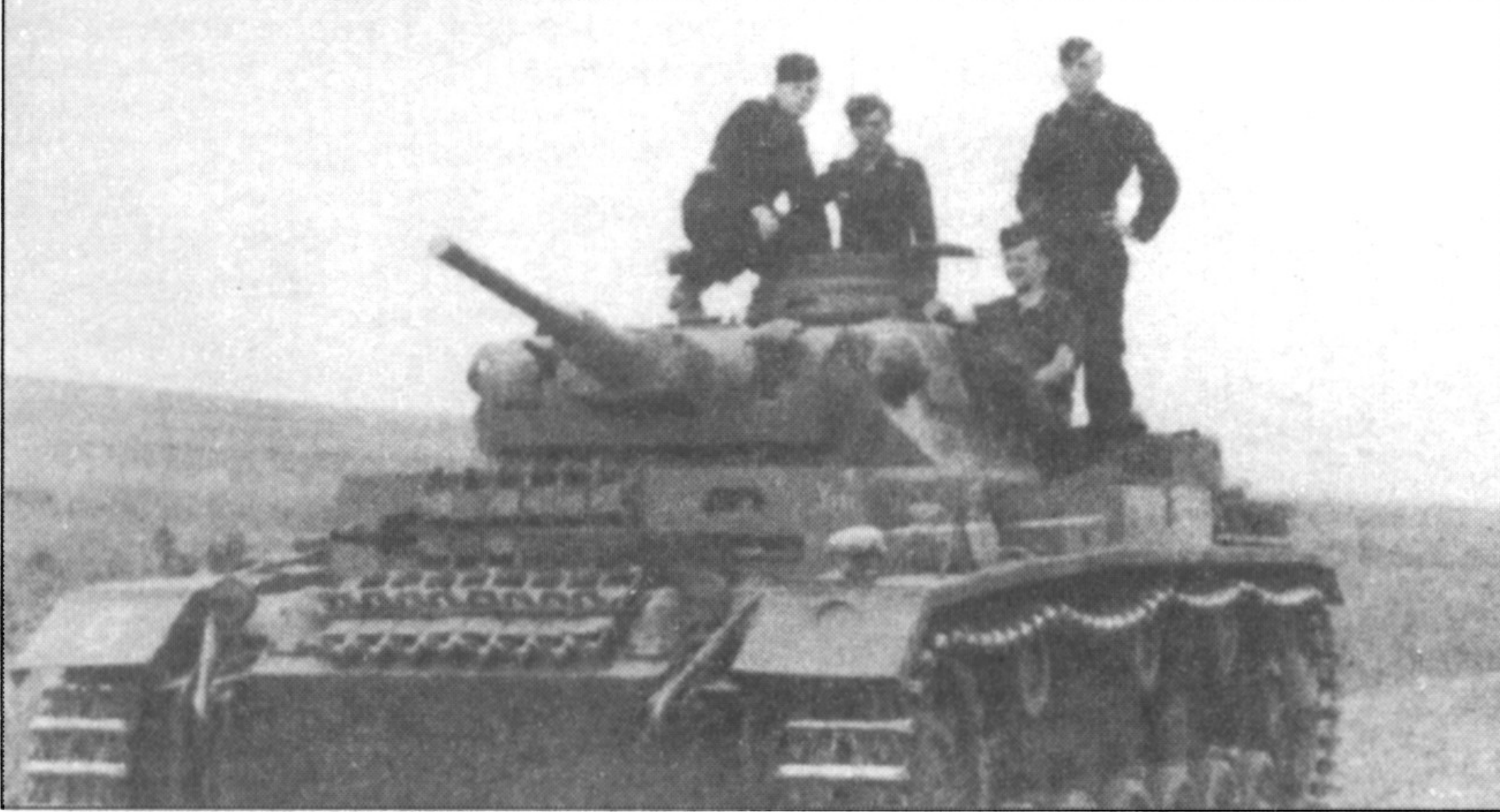
Ausf.F, перевооруженный 50-мм 42-калиберной пушкой, видна установленная на болтах накладная броня на верхнем лобовом листе корпуса и лист накладной брони приваренный к лобовому бронелисту надстройки. Справа от наблюдательного прибора механика-водителя - эмблема 10-й танковой дивизии.
