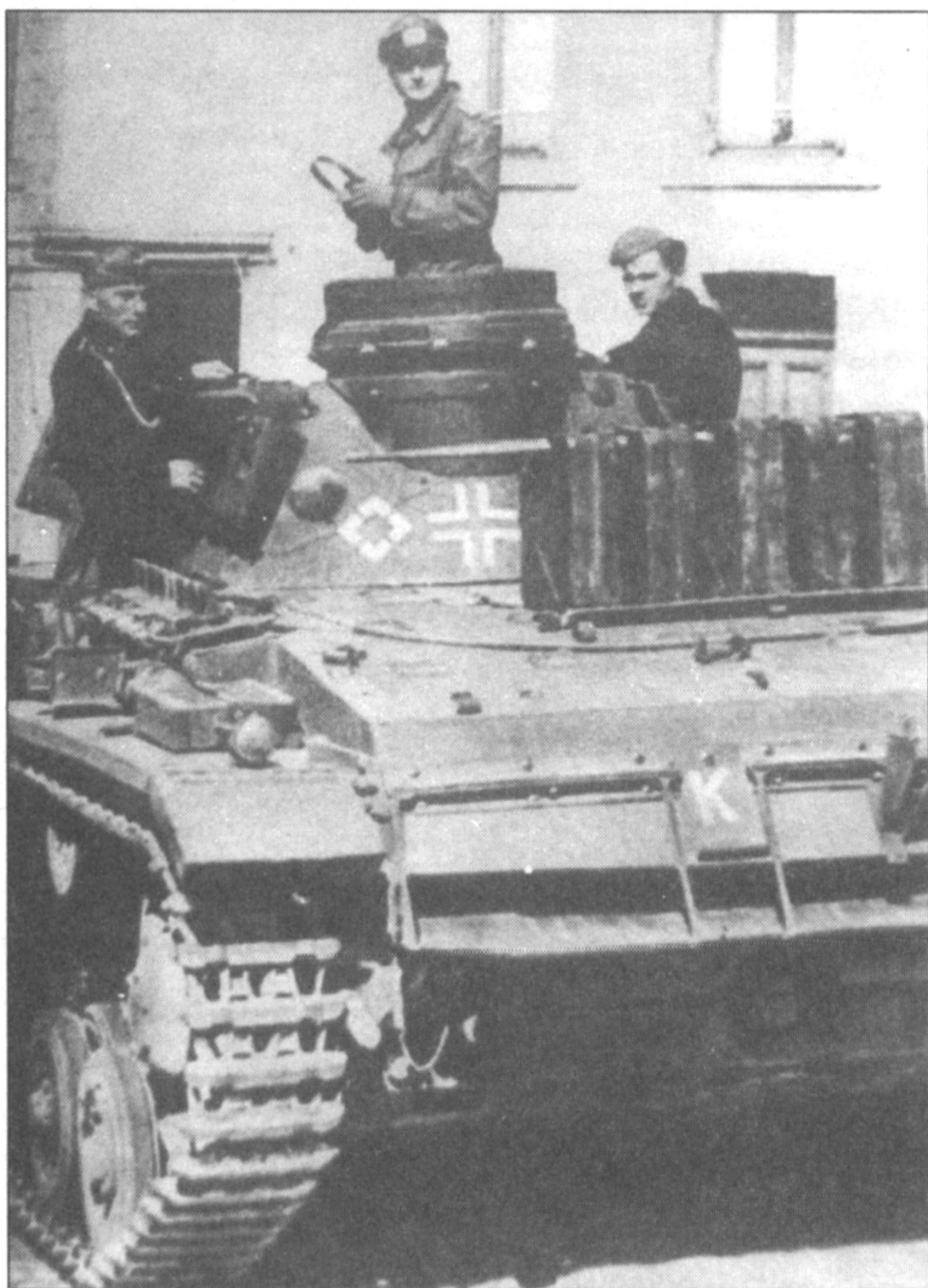
Замаскированный Ausf.E готов к бою. Хорошо видна 37-мм пушка. Особенностью ранних модификаций «тройки» являлась «внутренняя» маска пушки, которая была сильно уязвима от огня противотанковых средств.
