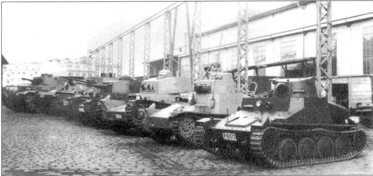
Прототипы СКД, находившиеся на заводе в 1938 году. Справа налево: танкетка R-1, танкетка AN-IVSv (для Швеции), легкие танки LTH и LTL (для Швейцарии и Латвии). Крайний справа - прототип LT vz.38.
